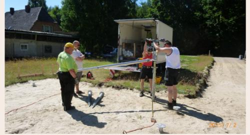
Eindrehmaschine mit Drehmomentaufzeichnung
