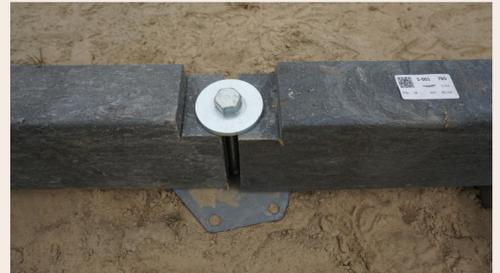
Verankerung Fundamentbalken Fundamentschraube
