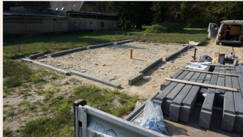
Fundamentbalken aus polyolefinen Werkstoff
