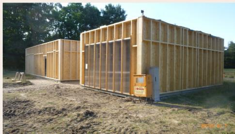
Rohbau auf 60 Fundamentschrauben, e = 125 cm
