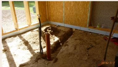
Fundamentbalken innen + aussen gedämmt
