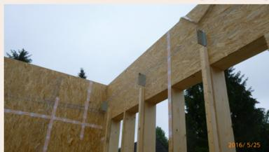
BFC Südwand, wärmebrückenfrei, WE2
