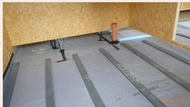
Lagerprofile 3/10 cm auf diffusionsöffener Unterspannbahn
