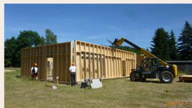
BFC Aufsetzen der Südwand WE1 auf Fundamentbalken
