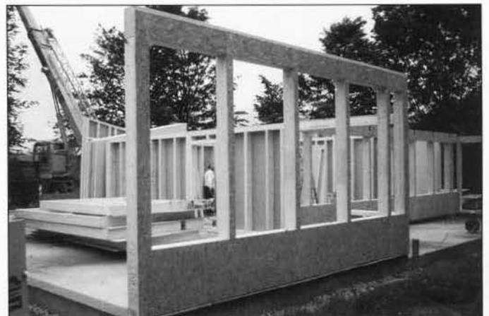
nen Wandelemente, die mit Zug- und Schubankern an die Stahlbeton-Bodenplatte angeschlossen wurden.
